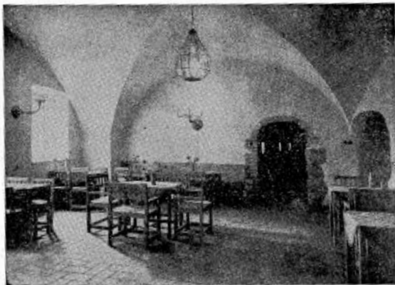
"Källarsalen" i Domtrappkällaren.
