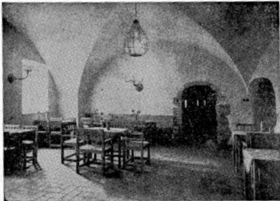
"Källarsalen" i Domtrappkällaren.
